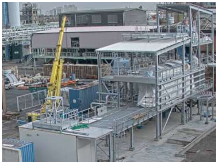
Standort Industriepark Höchst (im Bau)
